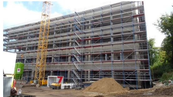
Der Rohbau des Zentrums für vernetzte Sensoren
