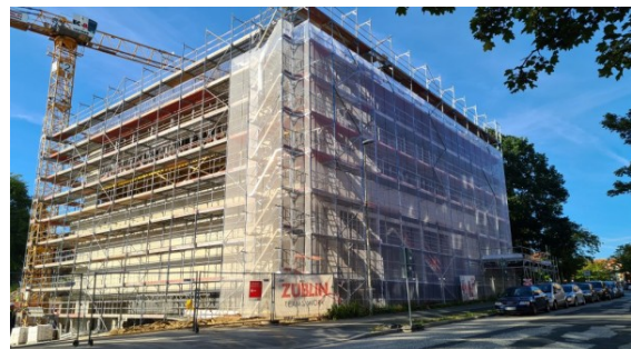
Der Rohbau des Hörsaalgebäudes
