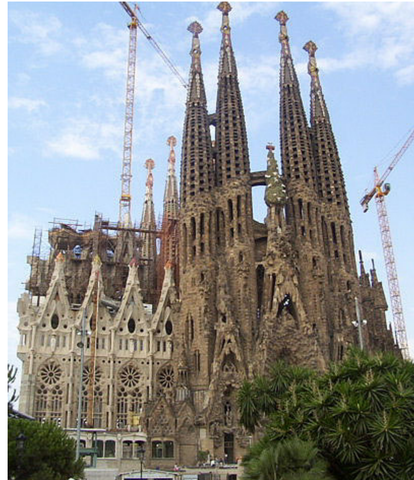
Seitenansicht des Bauwerks
